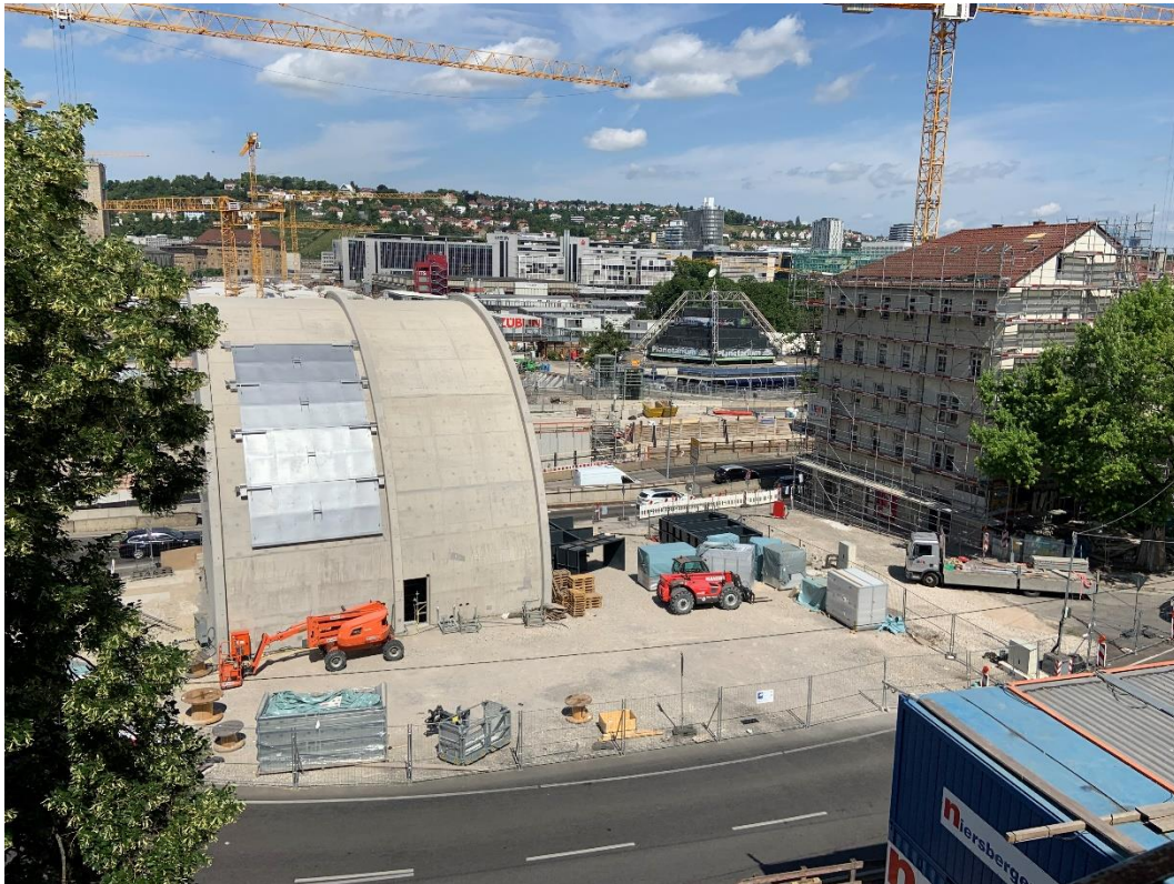
Abbildung 2: Blick auf das Baufeld bei Messende am 19.06.2023
