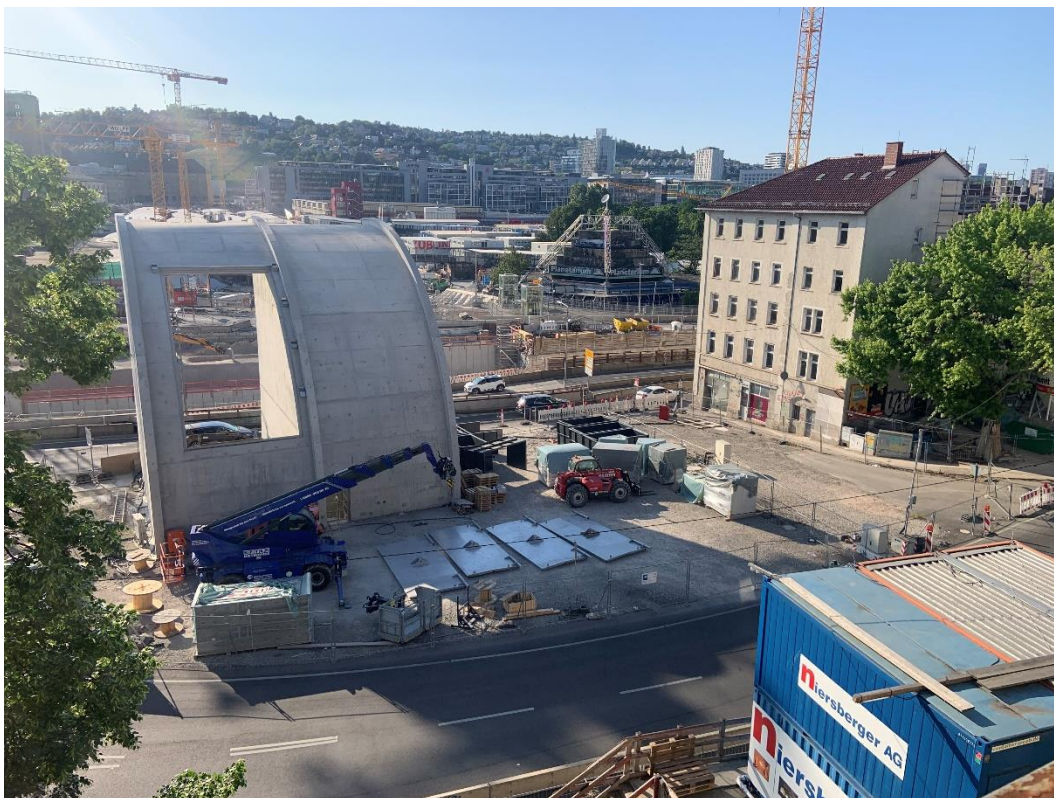
Abbildung 1: Blick auf das Baufeld bei Messbeginn am 30.05.2023
