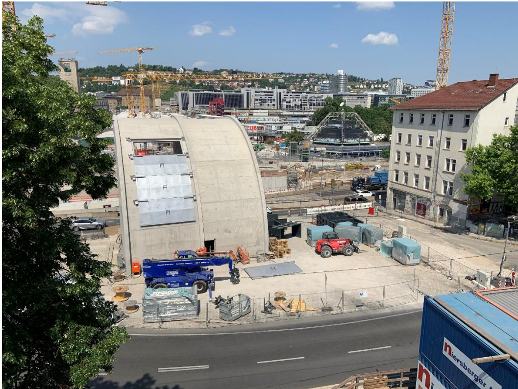
Abbildung 2: Blick auf das Baufeld bei Messende am 05.06.2023
