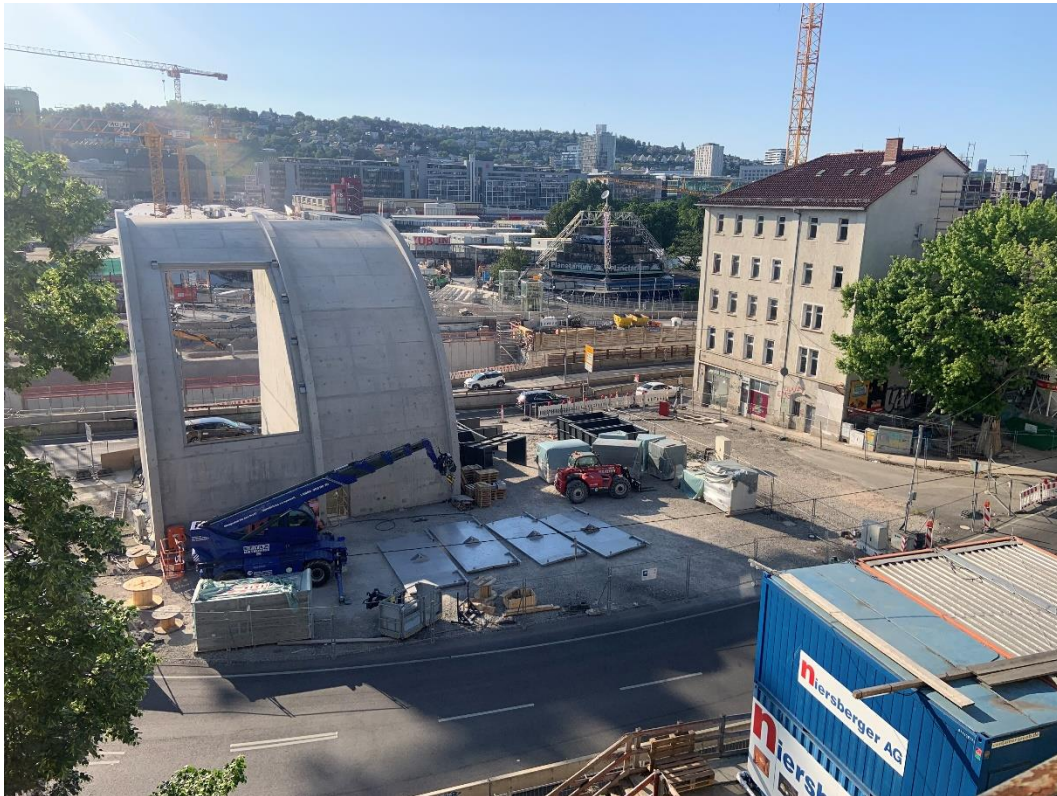
Abbildung 2: Blick auf das Baufeld bei Messende am 29.05.2023
