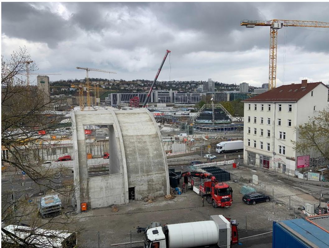
Abbildung 1: Blick auf das Baufeld bei Messbeginn am 17.04.2023
