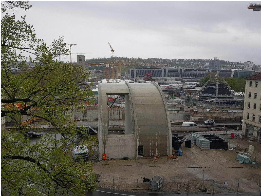
Abbildung 2: Blick auf das Baufeld bei Messende am 24.04.2023
