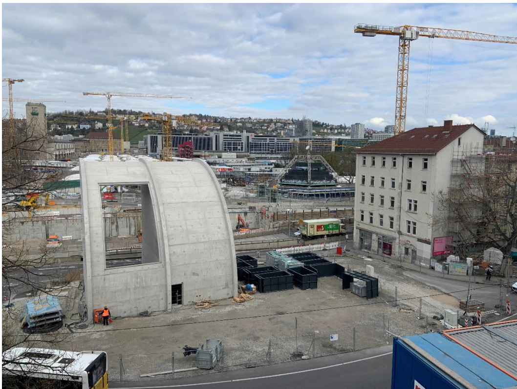
Abbildung 1: Blick auf das Baufeld bei Messbeginn am 03.04.2023
