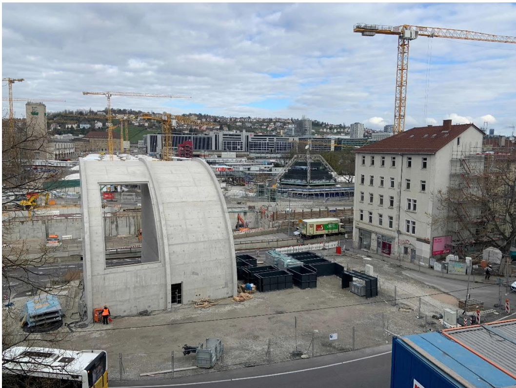
Abbildung 2: Blick auf das Baufeld bei Messende am 03.04.2023
