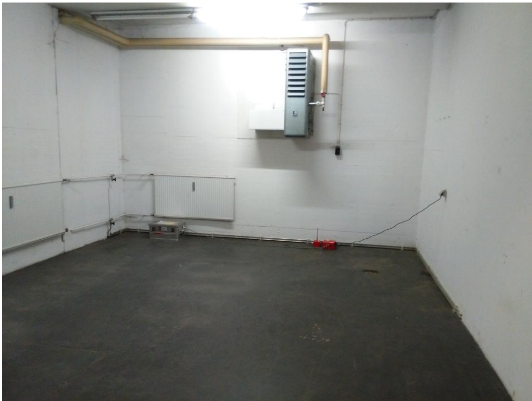
Abbildung 1: Neue Messposition im Gebäude Jägerstraße 14-18
