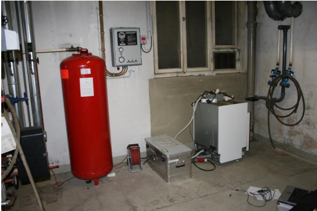
Abbildung 1: Messposition am Gebäudefundament
